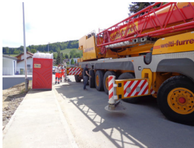
Der 100 t Autokran wird fachmännisch abgestützt, um das Bohrgerät (20 t) hinter das Haus zu heben.
