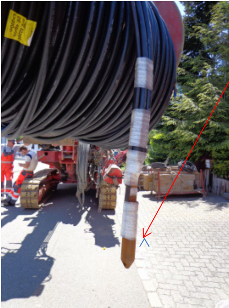
Eingepacktes Endstück der Erdsonde.
