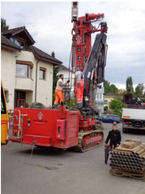
An Ketten wird das Bohrgerät an den Kran gehängt, und gehoben.
