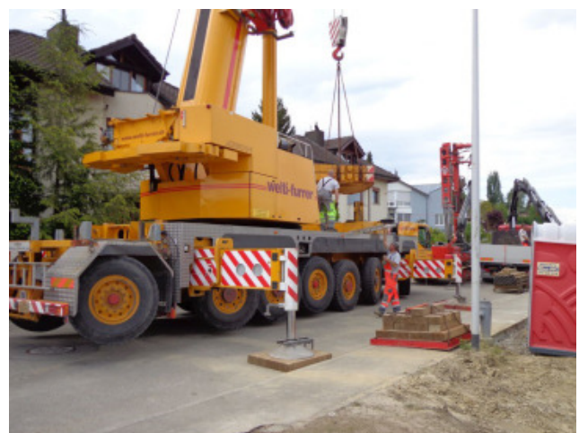
Das Gegengewicht für den Hebekran wird von einem separaten Transporter angeliefert, um den Autokran bei dieser schweren Last zu unterstützen.
