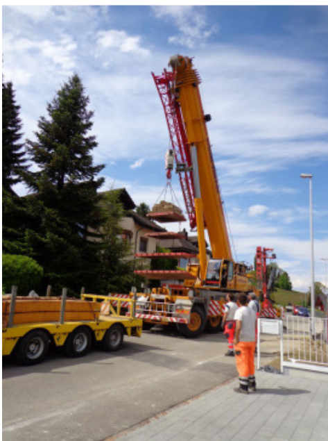
Das Gegengewicht für den Hebekran wird von einem separaten Transporter angeliefert, um den Autokran bei dieser schweren Last zu unterstützen.
